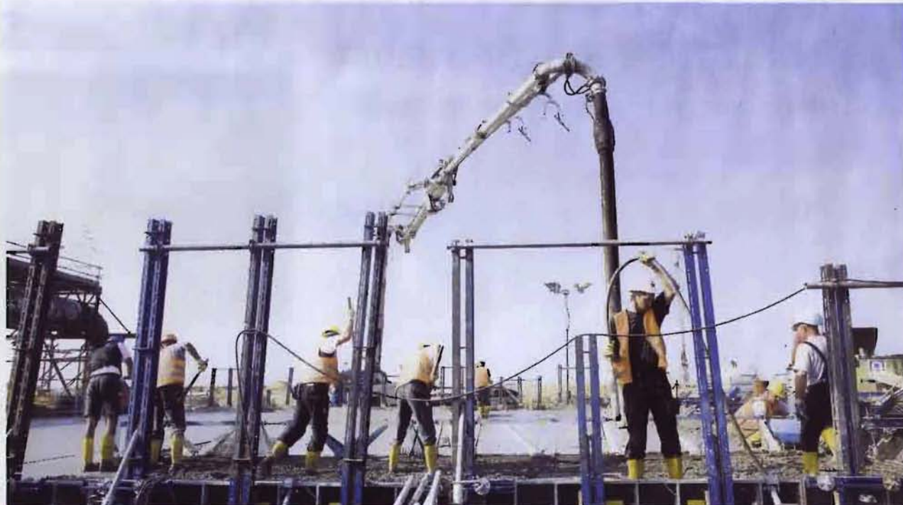
Baumängel am Haus? Nicht immer liegt der Fehler beim Architekten oder den Handwerkern: Gutachter suchen nach den Ursachen von Mängeln – und manchmal stellt sich heraus, dass die Hausbesitzer selbst gepuscht haben. Foto: Keystone
